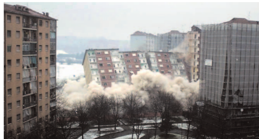
28 dicembre 2003 Abbattimento dell'edificio di via Fratelli Garrone 73
