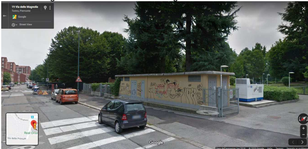
cabina 5 - via delle Magnolie 19 intervento sul lato lungo
