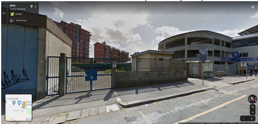
cabina 8 – via Pianezza 271/a – intervento su due lati (entro area privata)
