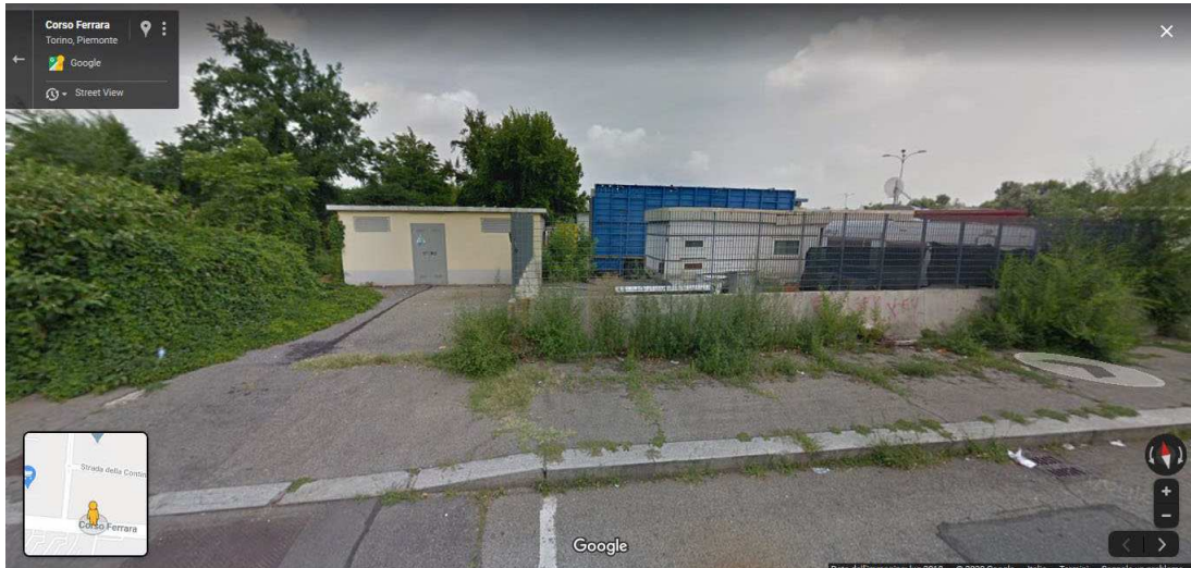
cabina 7 – corso Ferrara 40 – intervento su un lato
