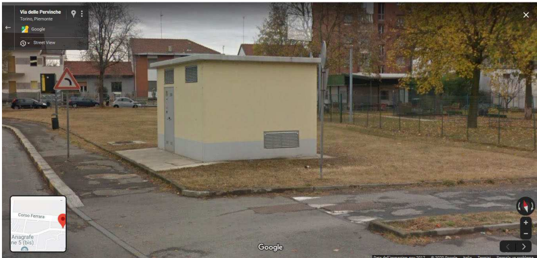
cabina 2 – via delle Pervinche 28 – intervento su 4 lati
