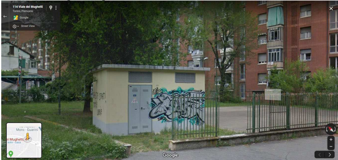
Cabina 1 – viale dei Mughetti ang. via delle Pervinche – intervento su 4 lati
