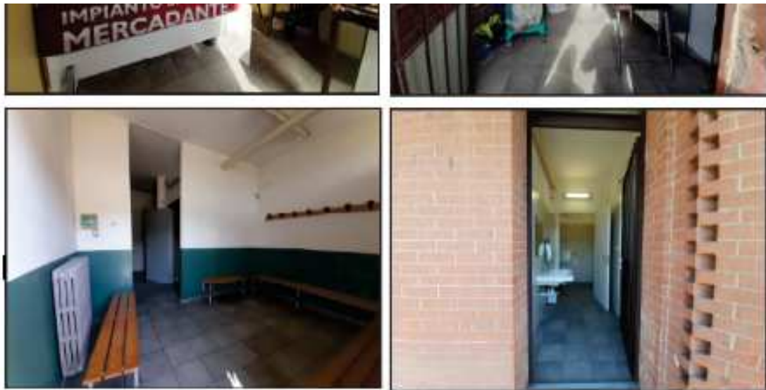
fabbricato piano interrato - vista ingresso, spogliatoi e locale cantina
